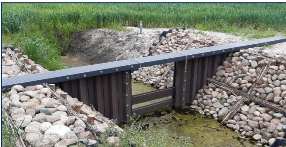
Rycina 7 Zamknięcie szandorowe zainstalowane na obiekcie melioracyjnym Grabów nad Pilicą (woj. mazowieckie). Projekt INOMEL, autorzy projektu urządzenia: E. Kaca, R. Oleszczuk (WBiŚ SGGW). Fot. B. Kierasiński
