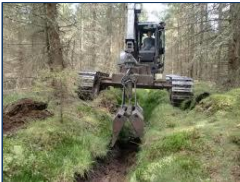
Rycina 48 Nowoczesny sprzęt „Varanen” do prowadzenia czynności utrzymaniowych sieci rowów melioracyjnych w Szwecji (fot. Anja Lomander)
