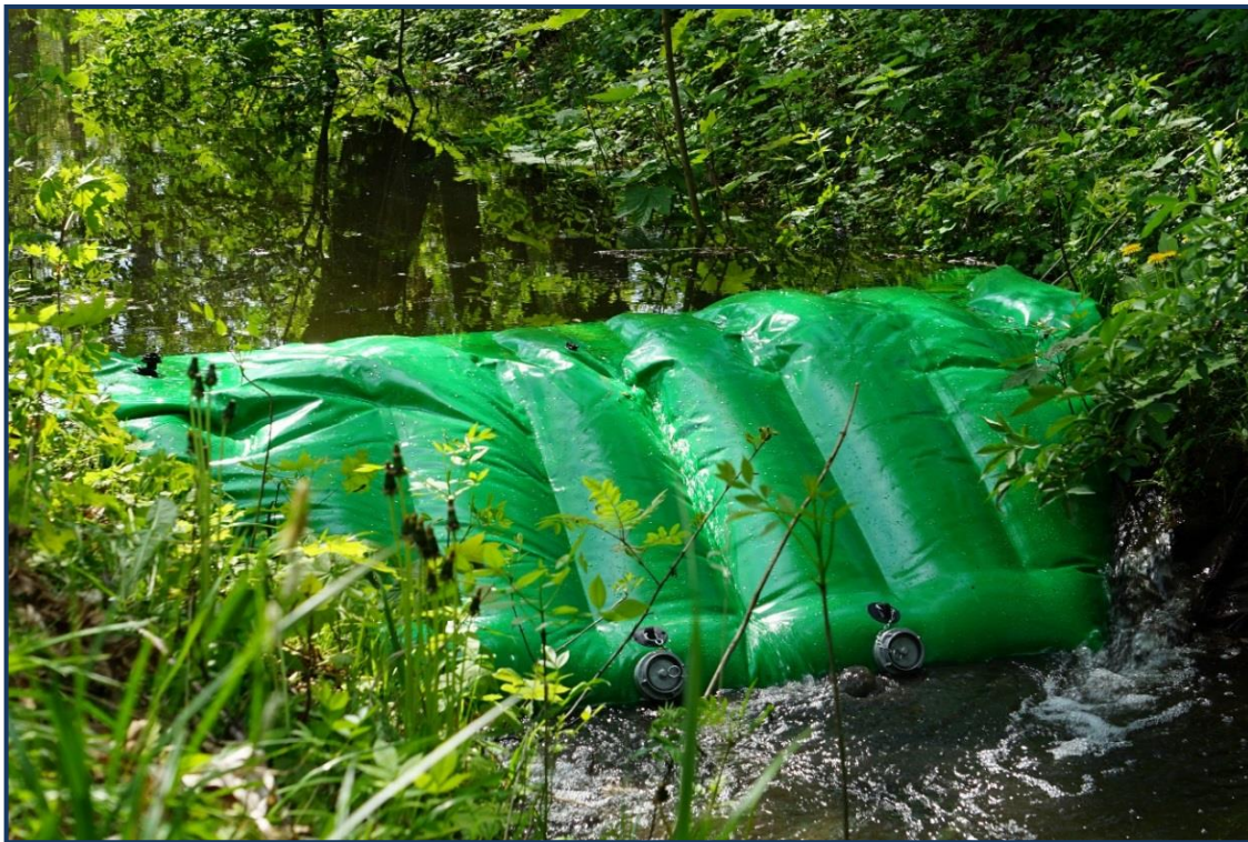
Rycina 9 Przenośny próg piętrzący wykonany z PVC, jako alternatywa dla stałych (betonowych i drewnianych) budowli piętrzących (fot. K. Karpińska)
