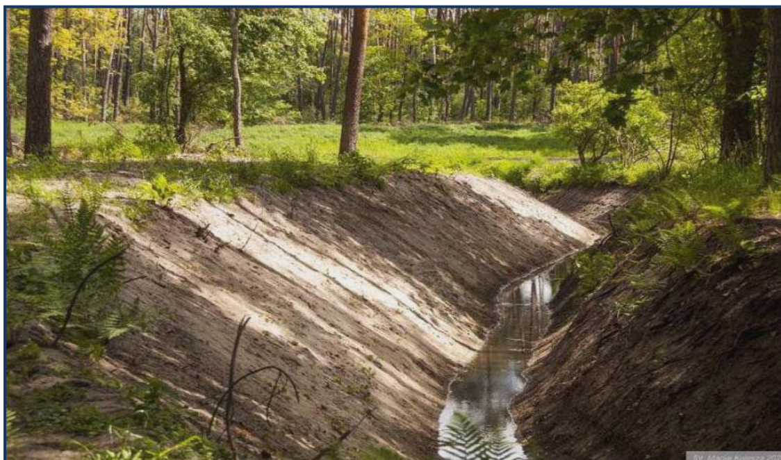
Rycina 47 Przykład wykonanej melioracji leśnej 78
