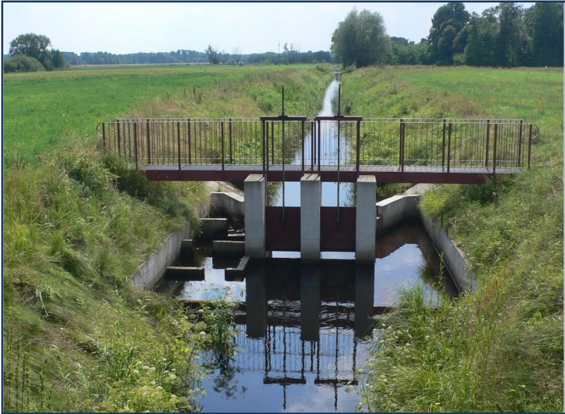
Rycina 16 Jaz z przepawką o charakterze technicznym na terenie Kampinoskiego Parku Narodowego (fot. Z. Kowalewski)
